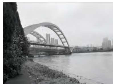
мониторинг деформаций мостов и тоннелей
